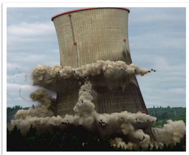
Slika 4.18. Rušenje rashladnog tornja kontrolisanom eksplozijom
