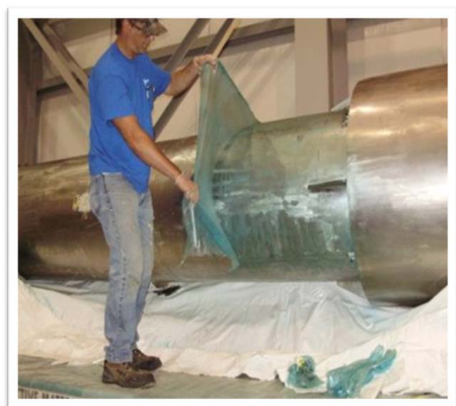
Slika 4.4 Neinvazivna dekontaminacija gelom
