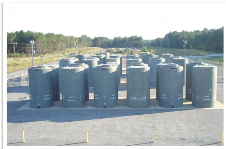
Slika 7.7. Skladištenje isluženog nuklearnog goriva u suvom skladištu
