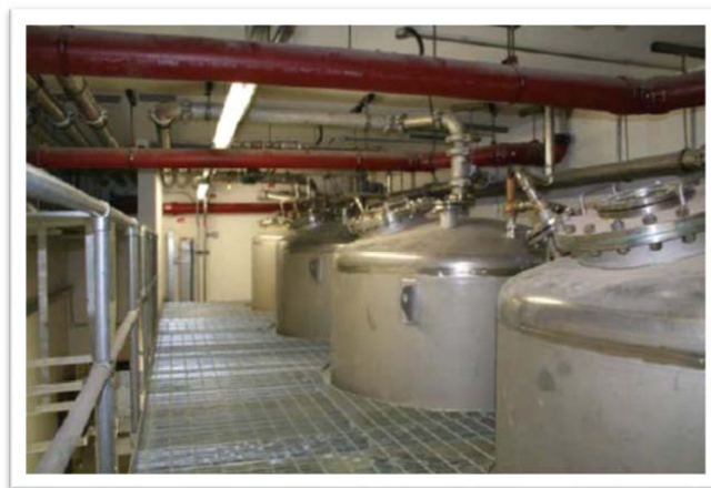
Slika 7.3. Rezervoari za tečni radioaktivni otpad (IAEA TECDEC1714, http://www-pub.iaea.org/MTCD/Publications/PDF/TE-1714_web.pdf )
