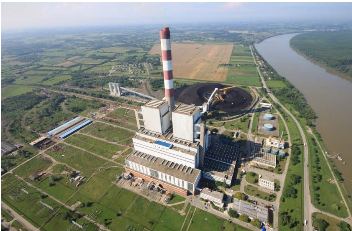
Slika 2.4: Termoelektrana Nikola Tesla B u Ušću.
