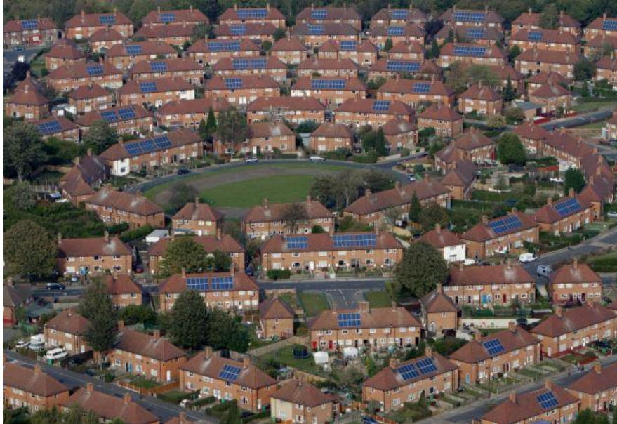
Slika 6.2. Fotonaponski sistemi integrisani u krovove i fasade zgrada
